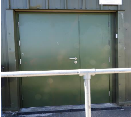
GADSAD's New Main Door
